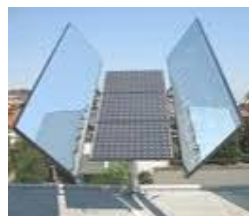
PANNELLI AL SUOLO CON SPECCHI CONCENTRATORI (α incidenza variabile)
