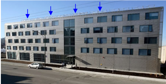
VISTA DEL FABBRICATO DAI PIANI ALTI DELL'EDIFICIO DI FRONTE
