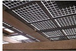
PERGOLA E PARETE BRISE-SOLEIL CON CELLE OPACHE AL SILICIO INTERPOSTE ALL'INTERNO DI LASTRE IN VETRO
