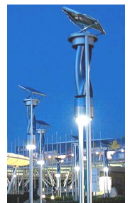
Lampioni con eolico + fotovoltaico
