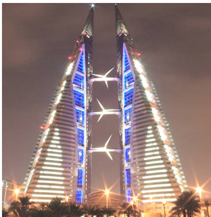
PROGETTI E REALIZZAZIONI DI ENORMI TURBINE EOLICHE IN GRADO DI SVILUPPARE DECINE E UN CENTINAIO DI KILOWAT, INTEGRATE SUL DESIGN DI GRATTACIELI
